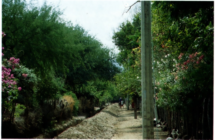
Aanleg van de waterleiding in San Vincente
